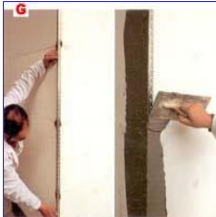
Una vez realizados los refuerzos, revestir la superficie de las placas de EPS, mediante una capa de mortero Traditerm y posteriormente peina con la llana dentada de 6 mm. Embeber completamente en esta capa la Malla Traditerm de armado de modo que haya un solapamiento de al menos 10 cm entre bandas verticales y las de refuerzo en las esquinas de todas las aberturas.
