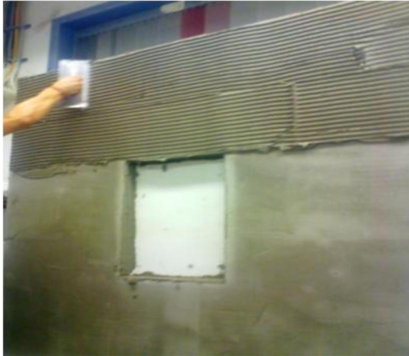
Pasadas un mínimo de 24 h. y con los surcos ya endurecidos, se aplica una nueva capa de mortero Traditem, la cual rellena los surcos y debe tener el espesor suficiente, para que a continuación, se peine con una llana dentada de 6 mm.
